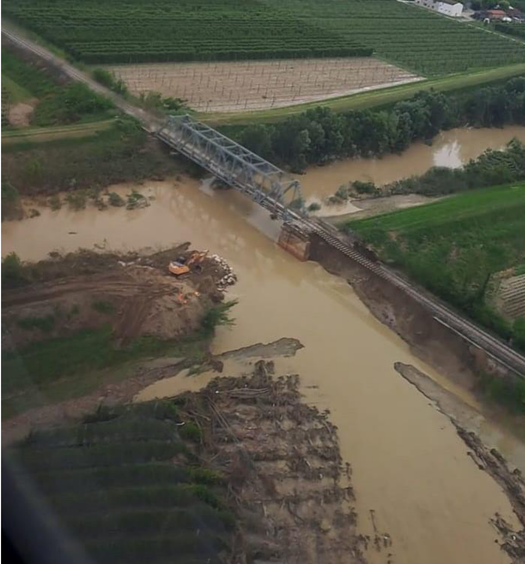
T. Santerno Sant'Agata sul Santerno. Chiusura rotta arginale, ricostruzione argine sinistro e rinforzo rilevato destro
