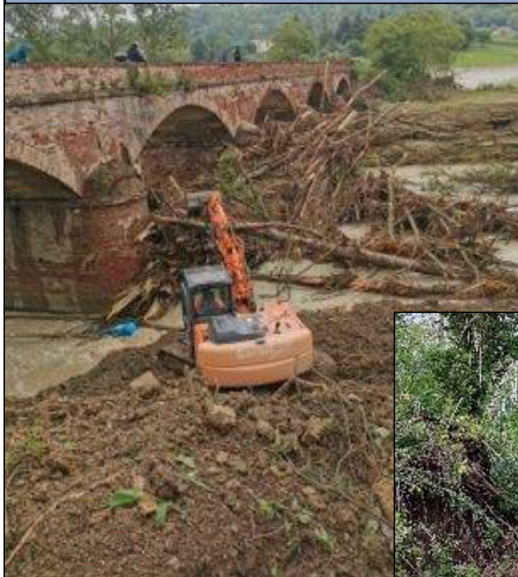
Pulizia vegetazione, rimozione accumuli e occlusioni
