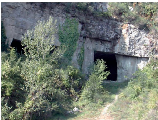
FIGURA 18: ingresso alle gallerie della cava della Marana.
