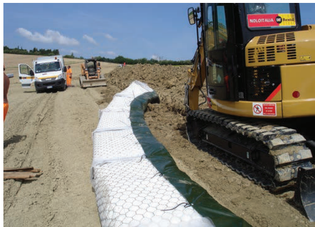
FOTO 4 - Fasi di lavoro con i mezzi di scavo e di movimento terra. L'organizzazione del lavoro e velocità di posa hanno permesso la realizzazione dell'intero sistema drenante in meno di dieci giorni
