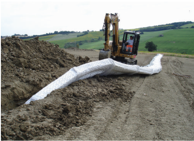
FOTO 2 - Operazioni di posa in trincea del sistema drenante. Si noti come parte della trincea si già alloggiata in scavo mentre in fondo si prosegue con il montaggio della linea in sicurezza fuori dallo scavo
