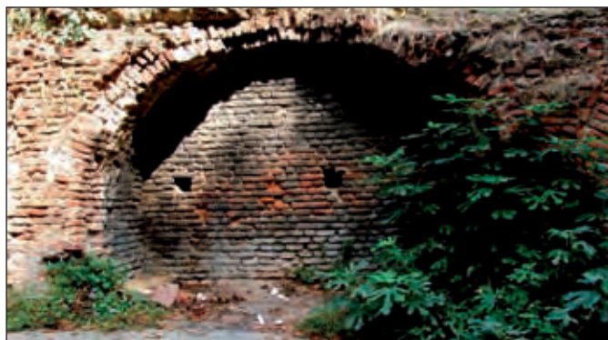
Figura 19 – Lacerto di un arco di cancella, presumibilmente, originale, quindi risalente al XIV secolo sito in via Mura di Porta Galliera, dietro la Montagnola. Si può notare come il livello circostante, in 600-700 anni, si sia notevolmente rialzato.
