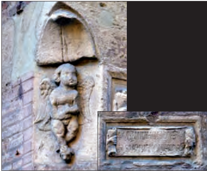
Figura 11 – Il puttino e l’iscrizione (il primo a sinistra, la seconda a destra) nel monolite in arenaria posizionato, in alto [a circa 3.30 m da terra], all’angolo tra via Guido Reni e vicolo Fantuzzi. Il degrado non permette di capire con certezza né cosa il puttino stringa tra le braccia [un’oca?], né su cosa poggia i piedini [una testa di cane?]. L’iscrizione, al contrario, si legge ancora piuttosto bene. La mano che svolge il cartiglio sulla sinistra è ancora ben visibile mentre quella sulla destra è quasi del tutto scomparsa. Il segno diacritico P con la barra sotto che compare all’inizio delle due righe e all’interno della parola SUPBIA nella seconda riga va letto: PER.
