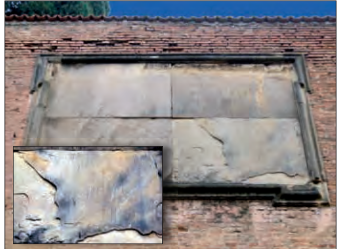
Figura 4 – La grande lapide collocata sul muro di cinta dell'antico convento di s. Maria degli Angeli, in via s. Caterina. Si vede chiaramente che essa è un collage di quattro lastre rettangolari in arenaria, identiche per dimensioni, circondate da una cornice, anch'essa in arenaria con modanatura, composta da 10 elementi. L'arenaria messa in opera con i piani di laminazione paralleli alla superficie esposta, si sta "squamando". Si può notare che il II quadrante, vale a dire quello in basso a destra [ingrandito in basso a sinistra], è il più degradato e quindi il più compromesso per quanto riguarda l'iscrizione.
