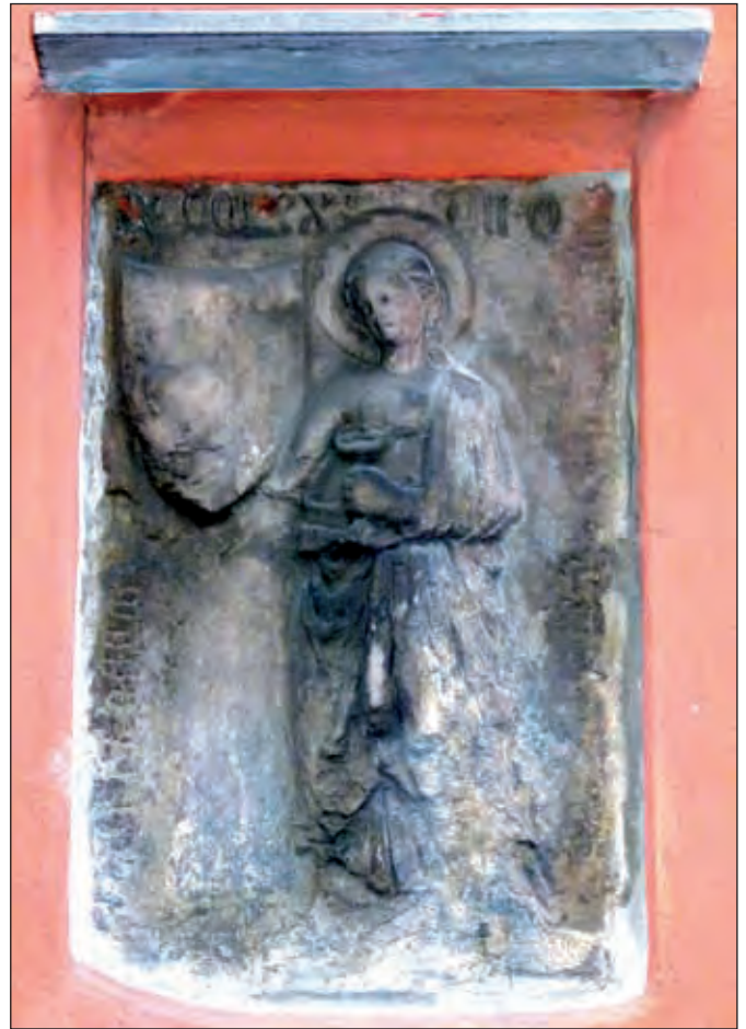
Figura 20 – La foto mostra lo stato del rilievo della s. Lucia oggi. Recentemente, ma tardivamente, l'immagine in arenaria è stata restaurata e protetta da un tettuccio in marmo che limita gli effetti dannosi dell'acqua ruscillante.
