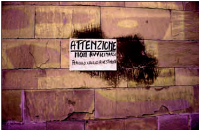
Figura 5 – Nonostante sia noto da tempo che le arenarie laminate non devono essere messe in opera coi piani di laminazione paralleli alla superficie esterna, di ciò molto spesso non si tiene conto. Questa modalità deve essere evitata anche nell'uso pavimentale pena la formazione in breve tempo di rotture concentriche che si addentrano nella pietra. Un esempio di quest'uso sconsigliato, a Bologna, è dato dalla pavimentazione della piazzetta antistante la chiesa di s. Maria dei Servi, in strada Maggiore, che dopo poco tempo dalla messa in opera dei conci è andata in rovina.
