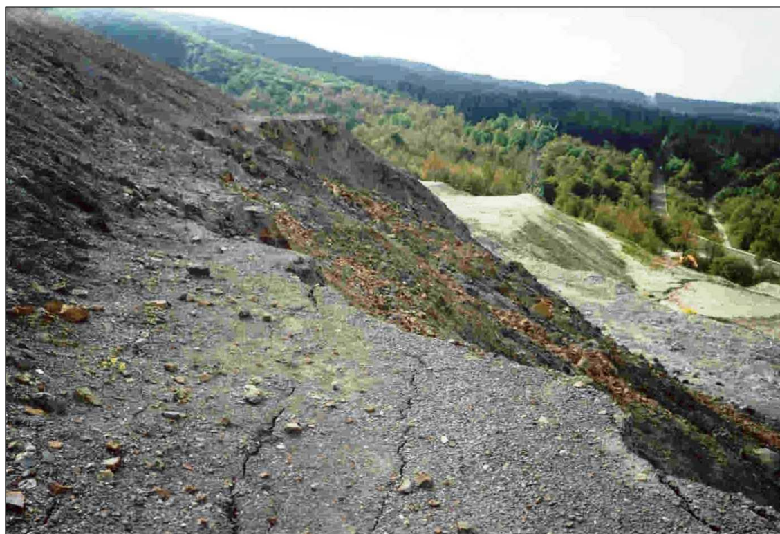
Foto 8 – Gradone principale di cava interrotto da movimento franoso che ha coinvolto prevalentemente materiali sciolti derivanti dal tipo litologico arenaceo-marnoso giacente come copertura tettonica (non stratigrafica) del calcare alberese.
