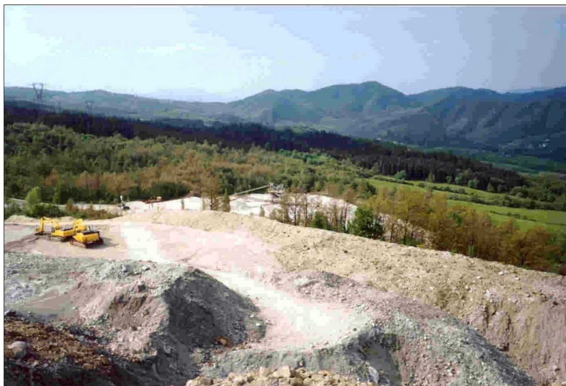
Foto 10 – Vista del piazzale inferiore (porzione centrale) fino al limite della strada provinciale.
