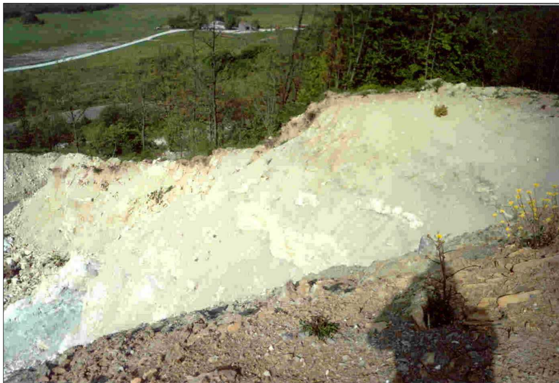
Foto 1 – Porzione NNW della parete di cava vista dall'unico soprastante gradone percorribile.
