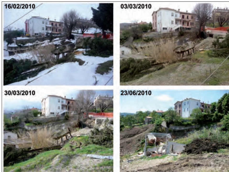
Figura 7 – Sequenza fotografica dell'evoluzione dal febbraio al giugno 2010. Nella prima immagine si osservano i lavori di realizzazione delle opere urgenti di presidio agli edifici posti nelle immediate vicinanze della zona di distacco. Si noti la traslazione della struttura su micropali sulla quale era installato un ripetitore per la telefonia mobile.
