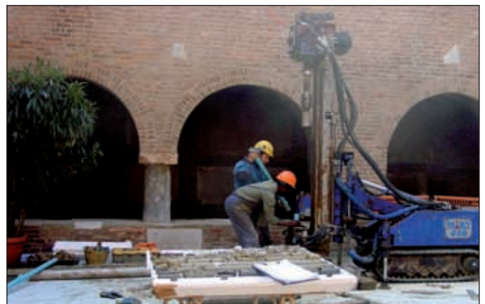
Figura 5 – Esecuzione del sondaggio S3 bis all'interno del Chiostro dei Benedettini.
