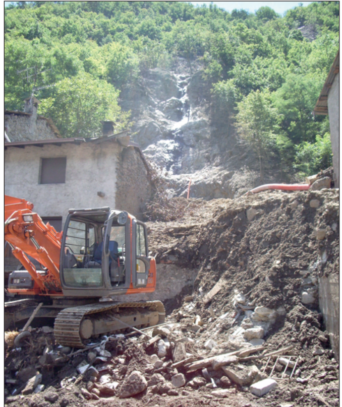
Figura 16 - Soil slip in Loc. Selvetta del Comune di Colorina (SO). Si nota bene come la frana abbia investito in pieno l'abitazione, abbattendone una parte (foto realizzata in data 23/07/2008).
