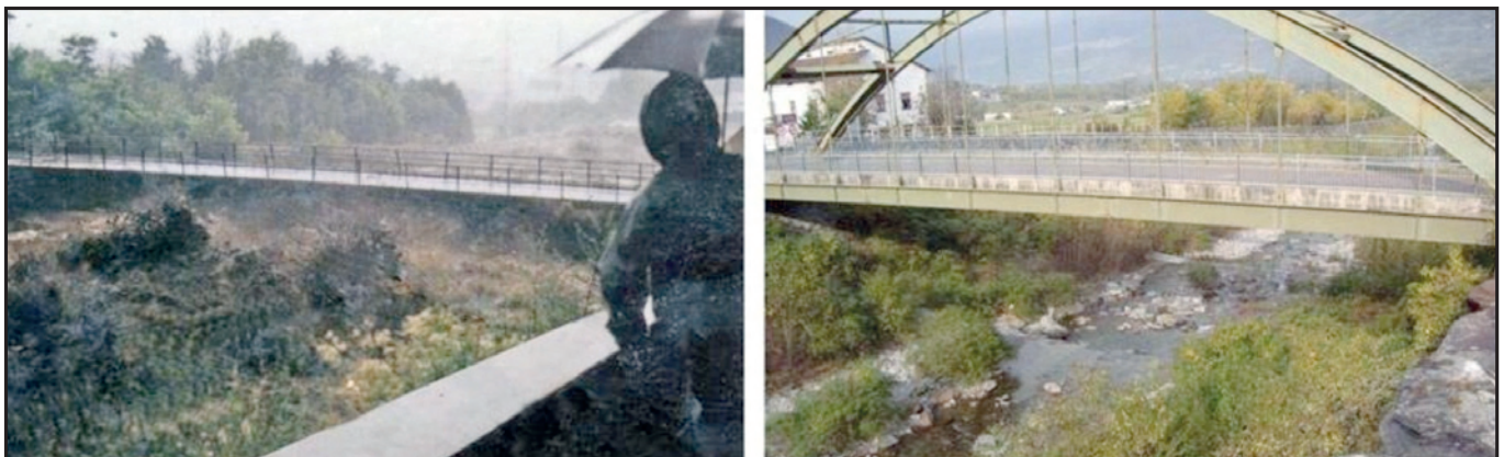
Figura 9 - Il ponte per Colorina il 18 luglio 1987 (sinistra) e ad ottobre 2008 (destra).
