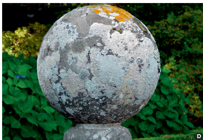
Fig. 3 - In assenza di superfici orizzontali è difficile che il processo di biodegrado vada oltre la colonizzazione della pietra da parte di licheni crostosi che tuttavia, tramite le ife fungine, porteranno a rilevanti modificazioni chimiche e fisiche del substrato. La colonizzazione su pietre silicee appare generalizzata con competizione tra i vari generi che si disputano tra loro gli areali [a, b e c: sarcofago etrusco, Toscana, nefro: tufo vulcanico tefritico; d: parco di Villa Lante, Bagnaia, ignimbrite latitica ].
