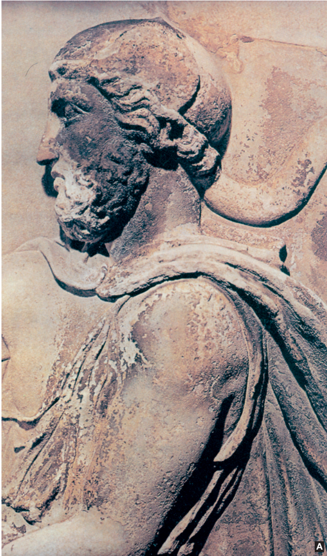
Fig. 29 a – Particolare del fregio del Partenone ancora in opera fotografato in situ. Il marmo bianco appare ricoperto da croste nere [costituita da particelle carboniose da combustione di oli e carbone in una matrice di solfato di calcio biidrato [gesso] da odierna inquinazione atmosferica] che ricoprono a loro volta precedenti patine bruno camoscio-rosso ruggine [costituite da ossalati e fosfati di calcio da precedente e oggi cessata biointerazione]. I celebri rilievi attribuiti a Fidia oggi conservati in gran parte al Museo Britannico a Londra, ma anche in piccola parte a Parigi e a Vienna dovevano presentarsi simili al particolare qui riprodotto prima di venire pesantemente ripuliti: tracce evidenti di queste patine restano sia sulle molte frazioni del British, sia sulle due del Louvre, mancano invece quasi completamente sul frammento conservato a Vienna. Dato che ossalati [e fosfati] sono dentro , e non sopra la pietra, il restauro ha portato a rimodellare le superfici come volute a suo tempo dall'Artista. Durante le operazioni di pulitura tese a rendere meglio leggibili i rilievi sarà sempre possibile eliminare completamente queste patine, quasi impossibile invece azzerare pitting e insulæ; b - Frammento dei rilievi del Partenone conservato a Vienna. Insulæ e pitting non lasciano dubbi sul fattore di danno – vale a dire biodegrado da antica colonizzazione lichenica - che ha martoriato le superfici del bassorilievo quand'era ancora in opera. Il marmo, privo delle caratteristiche patine brune, appare oggi bianchissimo: ciò contrasta in modo stridente con l'aspetto dei rilievi ancora in situ. Non v'è dubbio quindi che quest'opera sia stata pesantemente "restaurata" prima di venire esposta [Kunsthistorisches Museum, Vienna]; c - Lo stesso si può dire per i rilievi conservati al Museo Britannico [figura proveniente dal frontone Ovest del Partenone rappresentante il Dio fluviale Cefiso o Iliaso, particolare]; d - Anche il rilievo conservato al Louvre mostra esigue tracce di patine che un tempo, prima del restauro, dovevano certamente essere molto più estese [metopa con lotta tra un centauro e una lapitessa, particolare, marmo].
