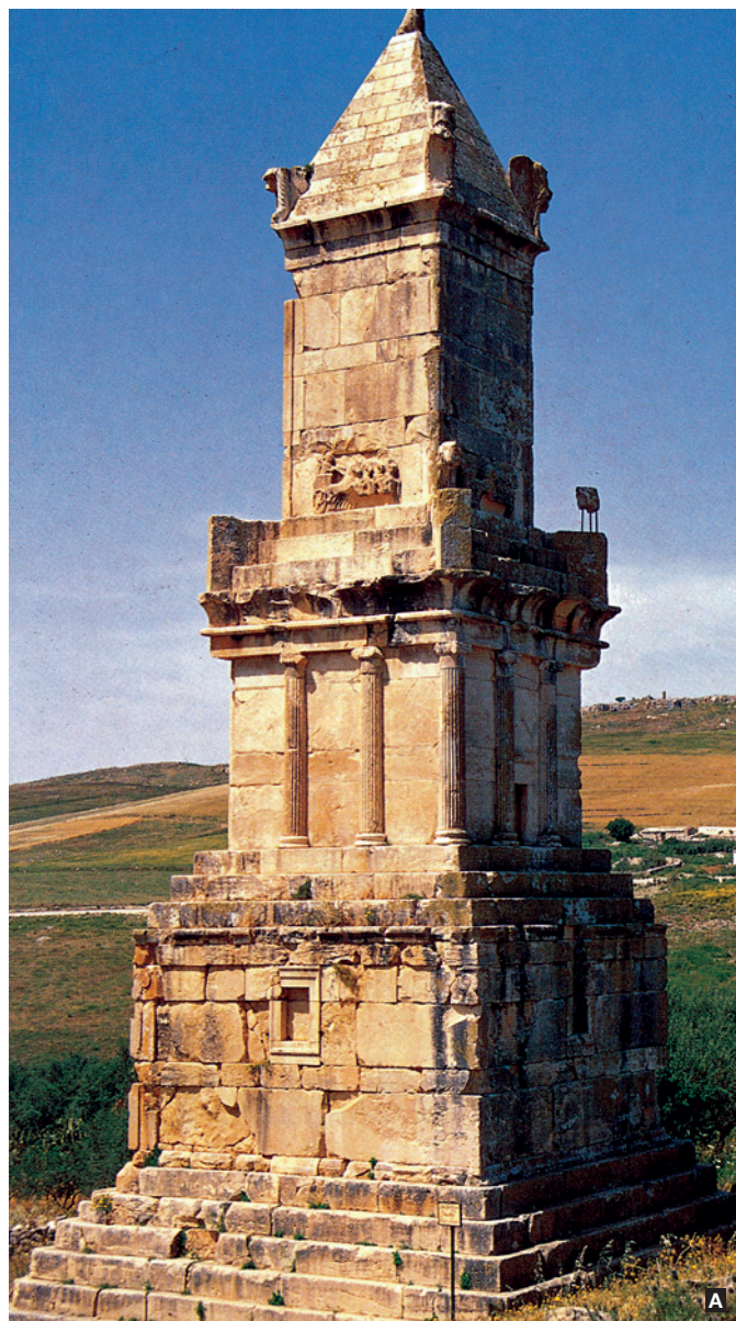
Fig. 28 – a : Il monumento è nelle parti aggettanti tappezzato di licheni viventi, mentre nelle le parti sottostanti è patinato a ossalati di calcio [Monumento Libico-Punico, dintorni di Dugga, Tunisia]; b : particolare del monumento precedente. Nell’area sotto la quadriga, protetta dal rain-out è presente la patina a ossalati; c : le aree verticali, arretrate e superficialmente protette, sono patinate dagli ossalati mentre quelle orizzontali appaiono martoriare dagli apoteci di licheni oggi non più presenti [Arco di Severo Alessandro, Thugga, Tunisia, calcare]; questo fenomeno ci parla di un cambiamento di clima avvenuto tra la edificazione del monumento e i nostri giorni; d : in alto licheni viventi, in basso patine a ossalati: è interessante notare che in corrispondenza della frattura dove l’acqua di pioggia può ruscellare è presente una colonia lichenica [Efeso, via dei Cureti, Turchia, marmo].
