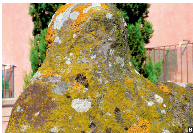
Fig. 3 - In assenza di superfici orizzontali è difficile che il processo di biodegrado vada oltre la colonizzazione della pietra da parte di licheni crostosi che tuttavia, tramite le ife fungine, porteranno a rilevanti modificazioni chimiche e fisiche del substrato. La colonizzazione su pietre silicee appare generalizzata con competizione tra i vari generi che si disputano tra loro gli areali [a, b e c: sarcofago etrusco, Toscana, nefro: tufo vulcanico tefritico; d: parco di Villa Lante, Bagnaia, ignimbrite latitica ].
