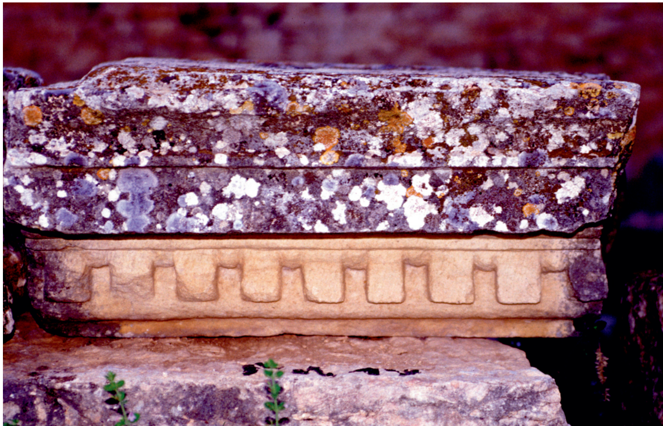
Fig. 10 – Nelle regioni rurali lontane da siti industrializzati, dove la qualità dell'aria è ancor'oggi buona, i licheni tendono a colonizzare completamente le parti aggettanti [sporgenti] delle pietre carbonatiche [calcari e marmi] vale a dire le aree non solo più illuminate ma soprattutto soggette all'azione diretta dell'acqua liquida di pioggia. Quindi sia le aree sub-orizzontali, sia quelle sub-verticali che limitano verso l'esterno il motivo ornamentale; i sottosquadri e le aree sottostanti arretrate appaiono invece quasi sempre ricoperte da una patina bruno camoscio assai caratteristica costituita da ossalati di calcio. Essa ha lo spessore massimo di alcune centinaia di \mu\text{m} , ed è spesso rimata vale a dire è formata da numerosi film sovrapposti. Sulla genesi della patina si parla lungamente nel testo a cui qui si rimanda. Tre sono i possibili motivi per cui queste aree non sono colonizzate: a - è probabile che i licheni non gradiscano aree ricche in ossalato di Ca che per loro rappresenta, principalmente, un prodotto di rifiuto; b - è probabile che i film sovrapposti di questa "vernice" impermeabilizzino la roccia sottostante rendendo da difficile a impossibile l'attecchimento delle diaspore; c - è probabile che queste zone dove vi è meno acqua o dove l'acqua si sofferma meno a lungo e che inoltre sono meno illuminate siano poco gradite ai pionieri per una eventuale colonizzazione. Quest'ultimo motivo è senza dubbio il meno probabile perché su pietre povere in calcio, come ad esempio i graniti [cfr. figura seguente], anche queste zone appaiono, molto spesso, colonizzate [Arco di Severo Alessandro, particolare, Thugga, Tunisia, calcare].
