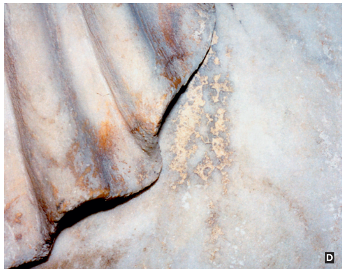
Fig. 29 a – Particolare del fregio del Partenone ancora in opera fotografato in situ. Il marmo bianco appare ricoperto da croste nere [costituita da particelle carboniose da combustione di oli e carbone in una matrice di solfato di calcio biidrato [gesso] da odierna inquinazione atmosferica] che ricoprono a loro volta precedenti patine bruno camoscio-rosso ruggine [costituite da ossalati e fosfati di calcio da precedente e oggi cessata biointerazione]. I celebri rilievi attribuiti a Fidia oggi conservati in gran parte al Museo Britannico a Londra, ma anche in piccola parte a Parigi e a Vienna dovevano presentarsi simili al particolare qui riprodotto prima di venire pesantemente ripuliti: tracce evidenti di queste patine restano sia sulle molte frazioni del British, sia sulle due del Louvre, mancano invece quasi completamente sul frammento conservato a Vienna. Dato che ossalati [e fosfati] sono dentro , e non sopra la pietra, il restauro ha portato a rimodellare le superfici come volute a suo tempo dall'Artista. Durante le operazioni di pulitura tese a rendere meglio leggibili i rilievi sarà sempre possibile eliminare completamente queste patine, quasi impossibile invece azzerare pitting e insulæ; b - Frammento dei rilievi del Partenone conservato a Vienna. Insulæ e pitting non lasciano dubbi sul fattore di danno – vale a dire biodegrado da antica colonizzazione lichenica - che ha martoriato le superfici del bassorilievo quand'era ancora in opera. Il marmo, privo delle caratteristiche patine brune, appare oggi bianchissimo: ciò contrasta in modo stridente con l'aspetto dei rilievi ancora in situ. Non v'è dubbio quindi che quest'opera sia stata pesantemente "restaurata" prima di venire esposta [Kunsthistorisches Museum, Vienna]; c - Lo stesso si può dire per i rilievi conservati al Museo Britannico [figura proveniente dal frontone Ovest del Partenone rappresentante il Dio fluviale Cefiso o Iliaso, particolare]; d - Anche il rilievo conservato al Louvre mostra esigue tracce di patine che un tempo, prima del restauro, dovevano certamente essere molto più estese [metopa con lotta tra un centauro e una lapitessa, particolare, marmo].
