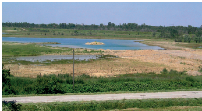
FOTO 10 – Vista panoramica della cassa di espansione di valle del T. Enza localizzata all'interno del polo G4 del PIAE (esaurito). (Comune di Montechiarugolo). (Foto dell'autore).
