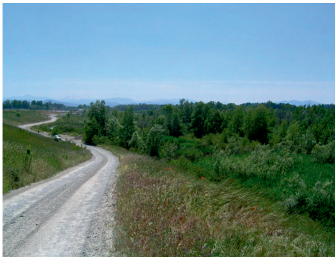
FOTO 1 – Le cave e l'ambiente: un binomio di non facile gestione, ma comunque possibile ... se si vuole. (Cassa di espansione di monte del T. Enza, Comune di Montechiarugolo). (Foto dell'autore).
