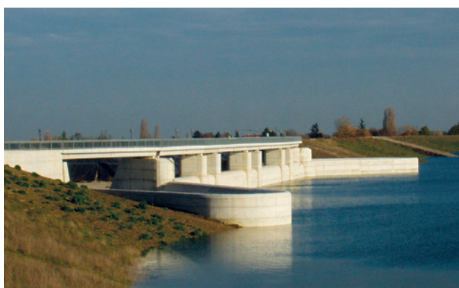
FOTO 11 – Il manufatto regolatore della cassa di espansione del T. Parma, localizzata all'interno del polo G3 del PIAE (ancora attivo). (Comune di Parma). (Foto dell'autore).
