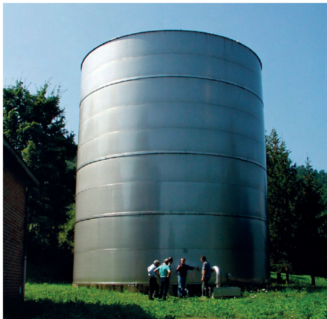
FOTO 6 – Il nuovo serbatoio di raccolta dello stabilimento Norda S.p.A. di Masanti di Sopra. (Comune di Bedonia). (Foto dell'autore).
