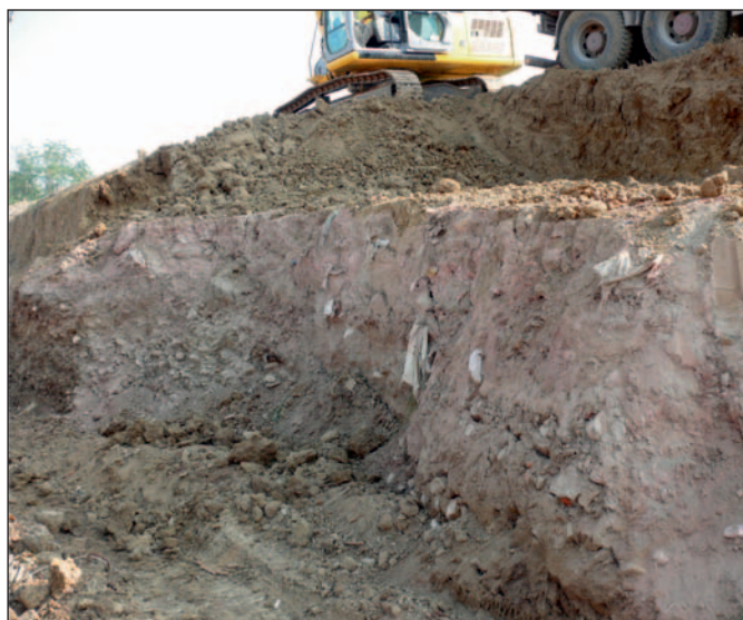
Figura 10 - Una fase della messa in sicurezza.
