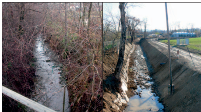
Figura 12 - Zona centrale prima e dopo l'intervento.
