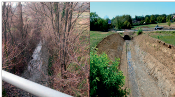
Figura 11 - Zona sud prima e dopo l'intervento.
