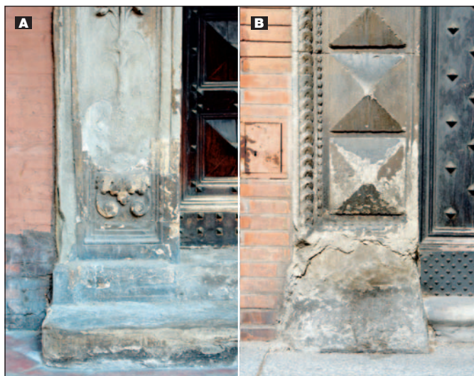
Figura 13 – Il degrado delle colonne, ma anche delle paraste, degli stipiti delle porte, avviene sempre a partire dall'imoscapo, vale a dire dalla parte più bassa a contatto col suolo. Ciò può accadere per diversi motivi, ad esempio perché sono quelle più soggette a urti, ovvero perché raggiunte di frequente dalla pipì dei cani maschi. Ma ciò accade anche quando si possono escludere queste cause: l'unico fattore di danno che si può invocare è allora l'acqua e la risalita capillare con tutto ciò che questo comporta (termoclastia accentuata, crioclastia, cristallizzazione di sali, dissoluzione, ecc.). Quando la parte a contatto del suolo appare come meno degradata di quella sovrastante il motivo risiede nel fatto che è stata restituita, forse, più volte (Bologna, a – Palazzo Felicini-Fibbia costruito alla fine del '400: la parte inferiore del montante sinistro del portone principale, in origine in arenaria grigio-azzurra è stato restituito utilizzando un arenaria gialla. b - Particolare del montante sinistro del portone d'ingresso del palazzo Guidotti-Senni). Un tempo non erano solo i cani a rappresentare un pericolo per le arenarie a livello del suolo: "Al di 10 ditte [settembre 1535] mandono la grida che nesuno non pissase a li pilastri del palazo del podestà perché quello pisse rogeghava le magegne di pilastri, e questo di ne fu messo in pregone 5". Così Giacomo Rinieri in: "Cronaca: 1535-1549".
