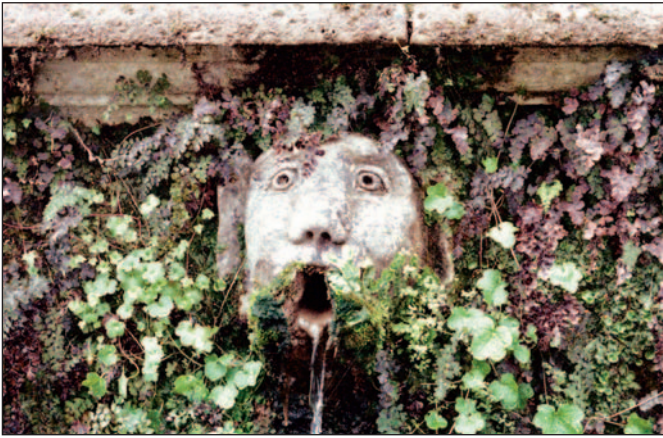
Figura 7 – Nei luoghi dove la qualità dell'aria è ancora buona un attivo fattore di danno è il biodegrado. La pietra viene attaccata dagli organismi vegetali soprattutto laddove le superfici sono orizzontali o suborizzontali, e trasformata lentamente in suolo. Il processo ha inizio con la colonizzazione del monumento da parte dei licheni, detti per questo organismi pionieri o precursori della pedogenesi. Perché ciò avvenga i tenori di SO_2 in aria devono però essere molto bassi ( SO_2 \leq 5 - 20 \mu g/m^3 di aria max) essendo questa sostanza, per questi organismi, un veleno mortale. Le città di vaste aree del pianeta, fortemente pollutate in seguito all'uso indiscriminato di combustibili fossili (carbone, olio e derivati, metano) sono state da tempo abbandonate dai licheni. Tutti i monumenti urbani antichi – precedenti all'Era Industriale che ha inizio col 1769, vale a dire con l'invenzione da parte di James Watt della macchina a vapore – se non sono stati successivamente "selvaggiamente restaurati" mostrano sempre i segni superficiali dell'antico biodegrado (Tivoli, giardini villa d'Este).
