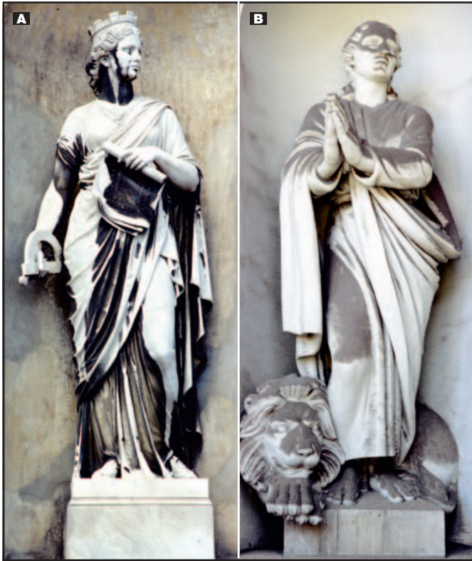
Figura 8 a - Una statua in calcare o in marmo, posta in campo aperto in una città dove la qualità dell'aria è cattiva, mostra una alternanza di aree bianche e nere. Le zone bianche sono quelle raggiunte dall'acqua di pioggia che allontana continuamente le polveri depositate: appaiono perciò bianche le parti più sporgenti e aggettanti. Apparentemente sembrano anche le zone più integre ma è proprio il contrario. L'acqua di pioggia non si limita a rimuovere le particelle depositate ma scioglie lentamente la superficie del calcare su cui scorre, assottigliandola. Le aree nere sono quelle non soggette al ruscellamento dell'acqua di pioggia: qui le particelle nere da combustione di olio o di carbone - nel caso qui mostrato di carbone - a reazione acida, si appiccicano alla superficie attraverso una reazione chimica che implica la trasformazione del carbonato di calcio sottostante in solfato biidrato di calcio, vale a dire \text{CaSO}_4 \cdot 2\text{H}_2\text{O} o gesso. Se il calcare o il marmo sono compatti la trasformazione riguarda uno spessore di poche decine o al massimo di qualche centinaia di micron. In un primo momento la superficie semplicemente si annerisce (soiling); col passare del tempo il film nero si trasforma in una vera e propria crosta nera che, se l'inquinamento dell'aria è severo, può raggiungere lo spessore di alcuni millimetri o addirittura di alcuni centimetri. b - Una statua, sempre in calcare o in marmo, posta a pochi metri dalla precedente, ma in una nicchia profonda quindi al riparo dall'acqua di pioggia, col passare del tempo, si ricopre di povere che si deposita, di preferenza sulle parti più esposte e suborizzontali. La polvere, vale a dire le particelle presenti in atmosfera e trasferite sulla superficie attraverso vari meccanismi - si parlerà di ciò in seguito - è semplicemente appoggiata e quindi potrebbe venire rimossa con facilità tramite un semplice aspirapolvere. Se in seguito a un evento eccezionale, ad esempio un forte temporale in presenza di vento, la polvere viene raggiunta da acqua liquida di pioggia la soluzione che si forma sarà molto acida e estremamente corrosiva nei confronti della pietra sottostante: gli esperti parlano in casi del genere di "shock acidi" o di "ondate" o "flussi acidi improvvisi" che portano alla formazione di piccoli solchi di corrosione subparalleli, detti microkarren . (a, b: Potsdam, Sanssouci Park).
