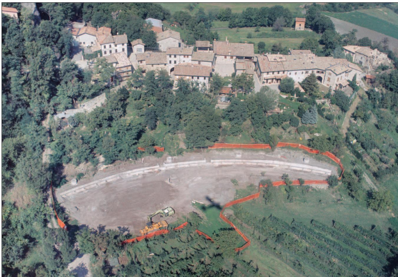
Figura 9 – Borgo di Rossena, Val d'Enza, Reggio Emilia. I lavori di consolidamento, pensati per difendere il borgo dal movimento della frana sottostante, sono eseguiti integrando opere strutturali (muro ad arco fondato su pali con tiranti) con pozzi drenanti di grande diametro, collegati sul fondo (sono visibili a tergo del muro). L'opera è posta in prossimità della scarpata principale e vuole impedirne l'arretramento. Foto G.Bertolini, 2006.
